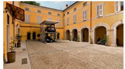
01 F Blick in den Innenhof mit angehobener Anlage zum Ausfahren aus dem unteren Stellplatz. A view into the courtyard with a lifted system ready for exiting from the lower parking place.
