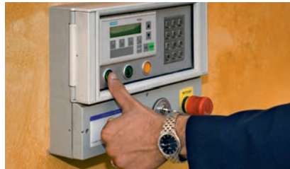
01 B Ein besonderes Bedientableau mit Schlüsselschaltung, Display, Zehntertastatur, Auf- Abtaster, Störmelde-taster und Not-Aus zur Bedienung der 3 x 3 Anlagen neben- und hintereinander. A special operating device with key access, display, digit number, up- and down, fault message and emergency button to operate the 3 x 3 units next and behind each other.
