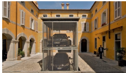
01 E steigt aus und senkt die Anlage wieder in die Grundstellung. Dann kann er seinen Schlüssel am Bedientableau abziehen und die Anlage verlassen. leaves the car and lowers the system until it has reached the ground position. Then he removes the key from the operating device and departs.
